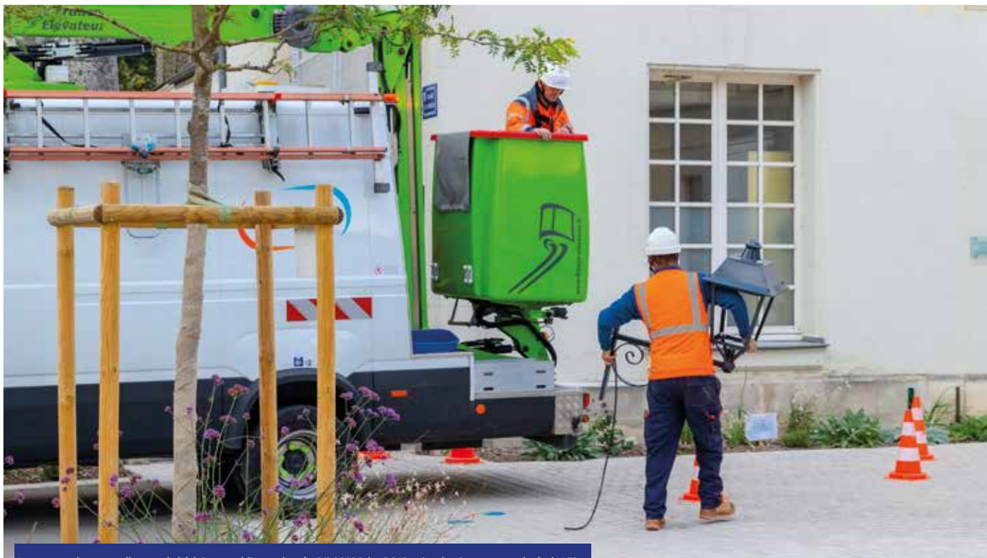
Les travaux de renouvellement de l'éclairage public sont lancés. D'ici 2026, les 2 212 points lumineux seront dotés de LED
