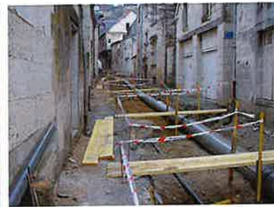
Aménagement en cours,
