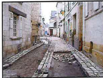
Aménagement en cours,
