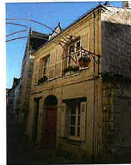
57 rue Haute Saint Maurice
