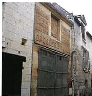
18 rue de la Lamproie
