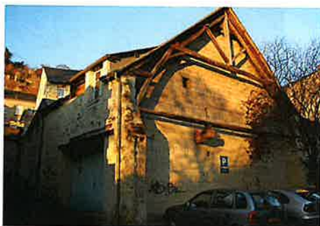
Hangar rue de l'ours
