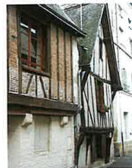
3 rue de la Lamproie
