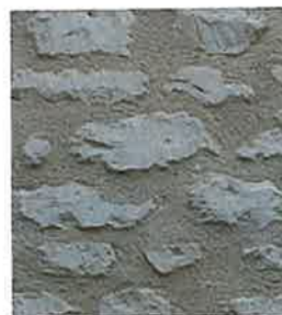
Enduit à "pierre vue"
