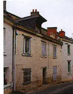
15 rue du Puy des Bancs
