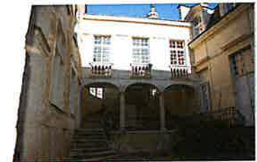
48 rue Haute Saint-Maurice
