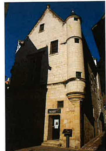
Tuffeau blanc pour la partie supérieure de la façade et la tourelle
