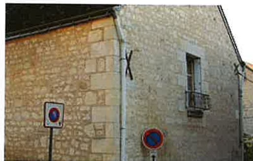
Traitement de l'angle par un chaînage
