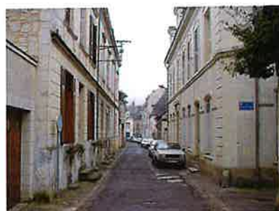
Photos Rue Marceau : Etat avant travaux, - source ville de Chinon - 2008
