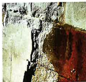
Colorations dues à l'émergence d'oxyde de fer venant de l'intérieur de la pierre
