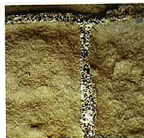
Effet produit sur le tuffeau par un liant mal adapté
