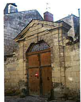
Hôtel, rue Haute St Maurice
