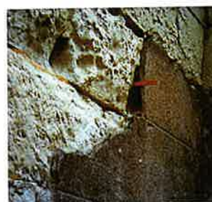
Illustration de la progression par diffusion de l'oxyde de fer dans le tuffeau
