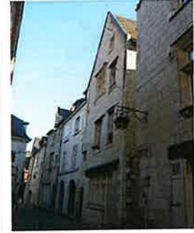
61 rue Haute Saint Maurice
