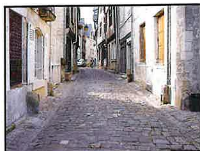
Photos Rue Voltaire : Etat avant travaux, - source ville de Chinon - 2008
