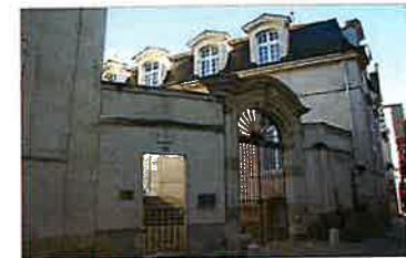
48 rue Haute Saint-Maurice
