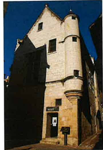
Tuffeau jaune, à l'angle sous la tourelle
