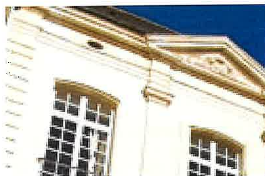
Exemple de corniche, et détail des moulurations.
