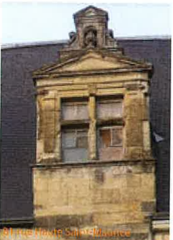
87 rue Haute Saint-Maurice
