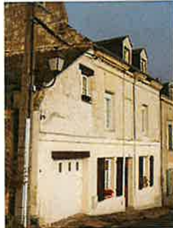
31 rue du Puy des Bancs
