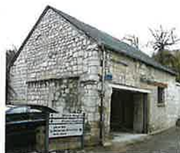
Garage 22 rue Marceau
