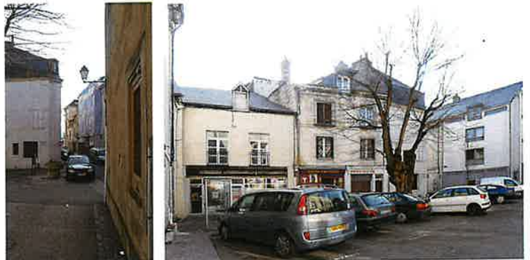
Façades au Sud de la place
