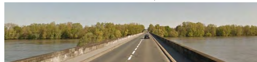
Pont de la Loire sur la commune d'Avoine
