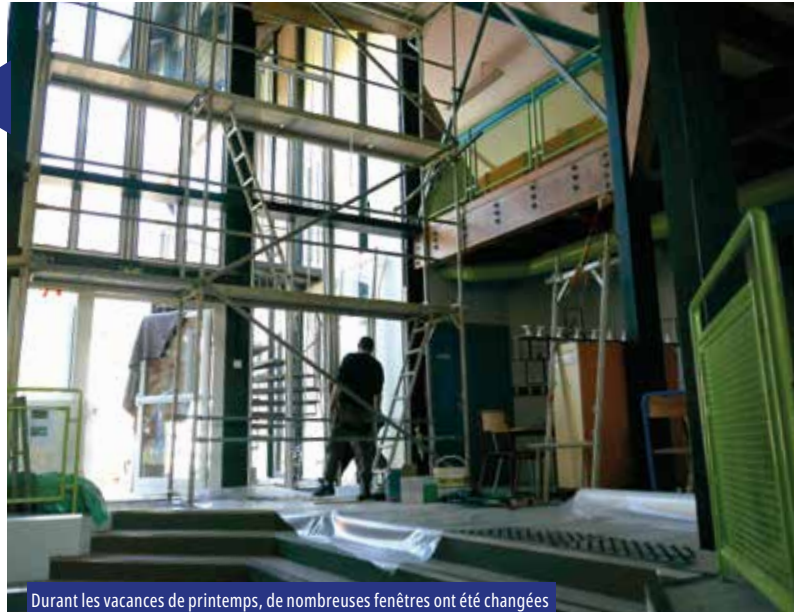
Durant les vacances de printemps, de nombreuses fenêtres ont été changées
