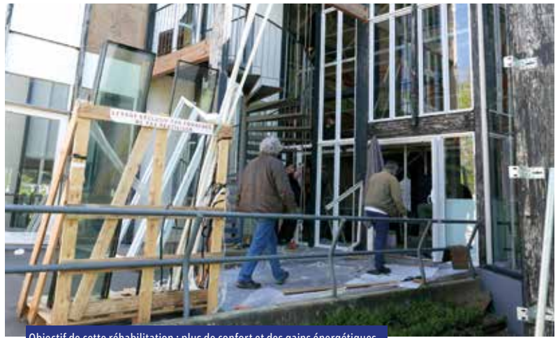
Objectif de cette réhabilitation : plus de confort et des gains énergétiques
