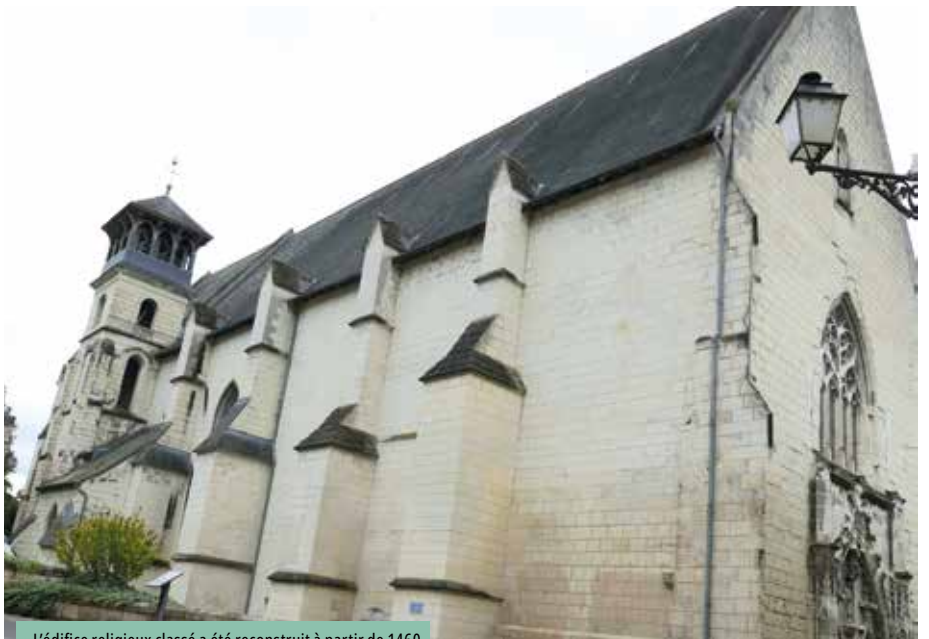
L'édifice religieux classé a été reconstruit à partir de 1460
