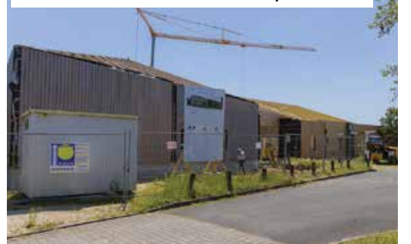
Les travaux au centre de loisirs se poursuivent
