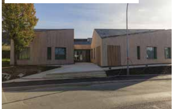
Aux Hucherolles, les travaux se finalisent
