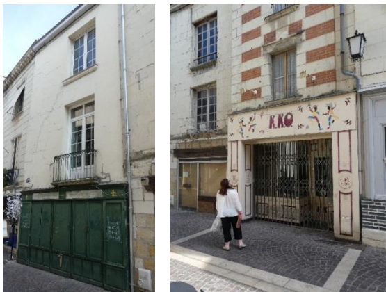
Maisons de ville avec boutique sans entrée indépendante
