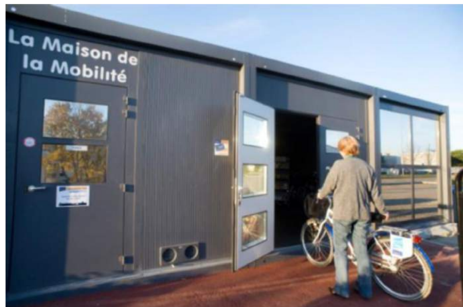
Exemple de la maison de la mobilité de Labège (commune de 4000 hab. près de Toulouse)
